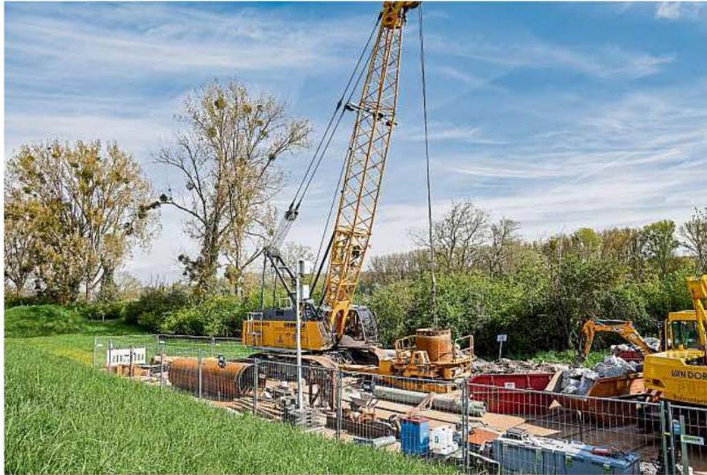
**Mithilfe eines 70 Tonnen schweren Seilbaggers wird momentan der Rückbau eines alten Brunnenrohres gestemmt. Die gesamte Sanierung des Trinkwasserbrunnens am Guntersblumer Rheinufer soll im Juli abgeschlossen sein.**
