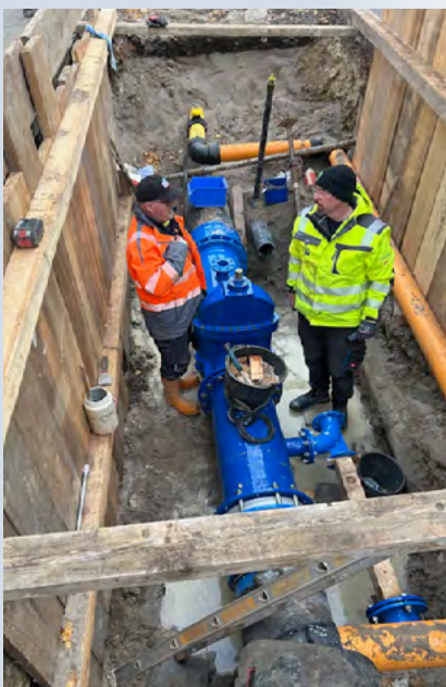
Erneuerung eines Schiebers auf einer Transportleitung in Alzey
