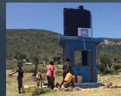
Hochbehälter in Kenia
