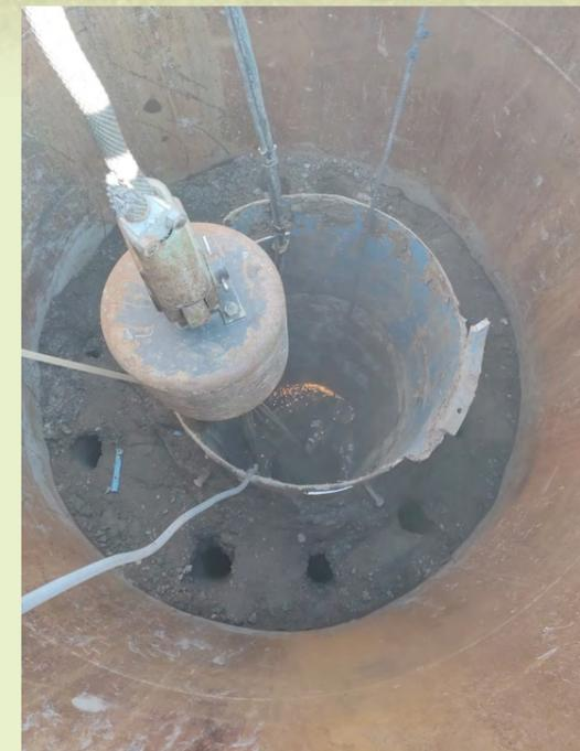
Funkenflug – der Bautaucher lässt beim Durchsägen des alten Rohrs im Innern des Brunnenschachts die Funken fliegen.
